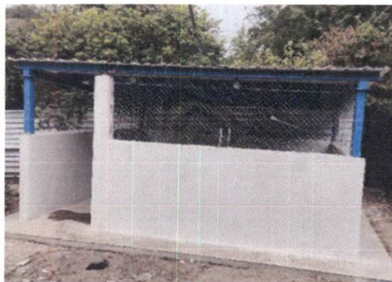
Foto 2: Mejoramiento de cocina de la escuela multigrado
