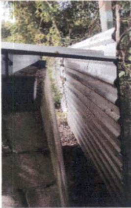
Foto1: Mejoramiento de baño (techo y taza) de la escuela multigrado
