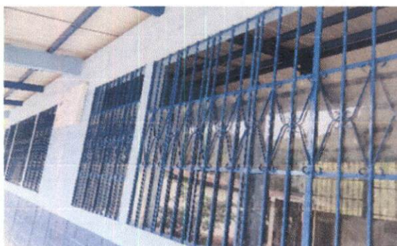
Foto 2: Mejoramiento de balcones y ventanas de aula multigrado de primero a sexto y bodega
