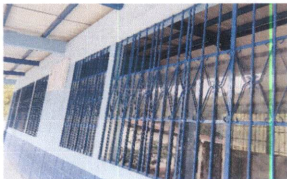
Foto1: Mejoramiento de balcones y ventanas de aula multigrado de primero a sexto y bodega
